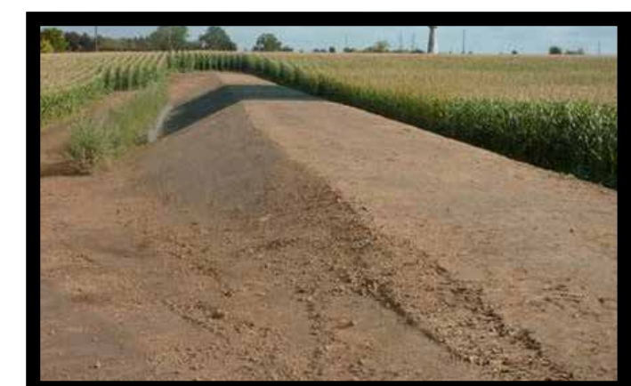
Digue de plein champ pouvant stocker plus de 2 000 m 3 en amont
