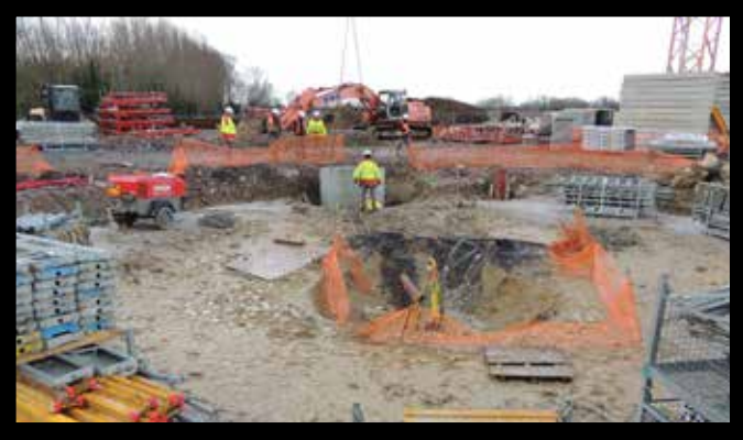
Ouvrier de chantier (station d'épuration de Richebourg)
