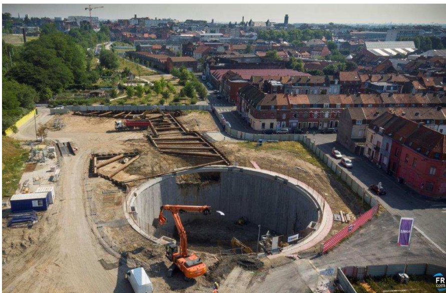
Chantier d'aménagement du bassin de Brondeloire à Roubaix / Crédit photo : Sogea Caroni
