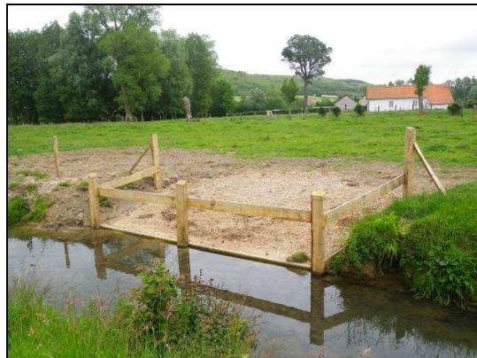
**Figure 23 : Vue d'un abreuvoir au fil de l'eau**
