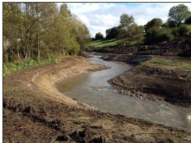
Figure 17 : Illustration d'un reméandrage de cours d'eau
