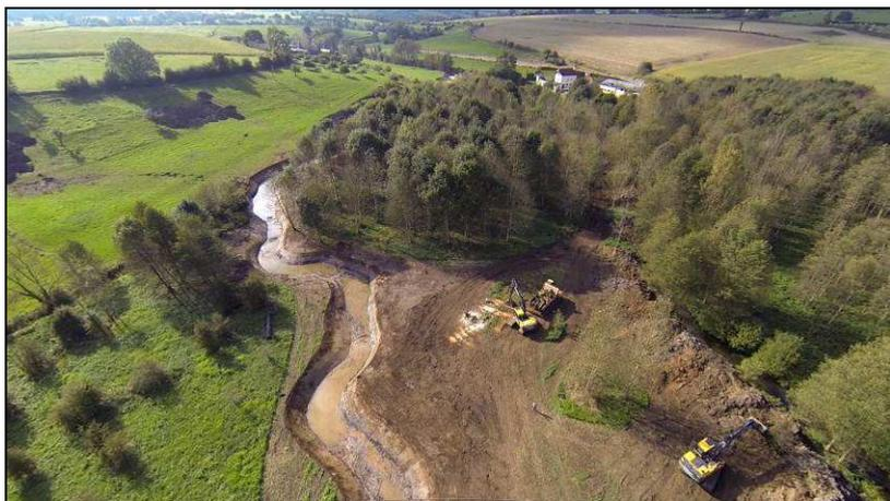
Figure 16 : Vue du ciel d'un reméandrage de cours d'eau
