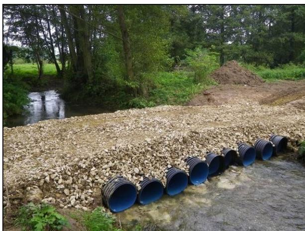
*Illustration d'un ouvrage provisoire de franchissement de cours d'eau*
