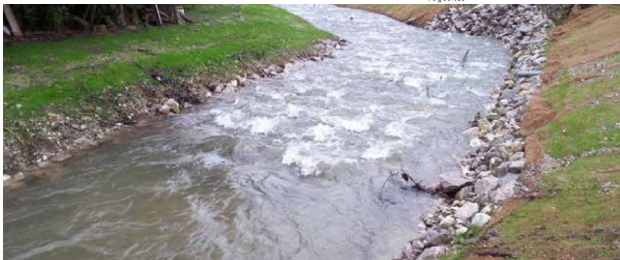
Seuil du moulin de Beussent après les travaux
