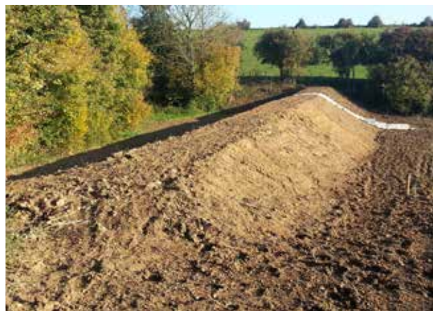
Aménagement hydraulique structurant : Digue de plein champ
