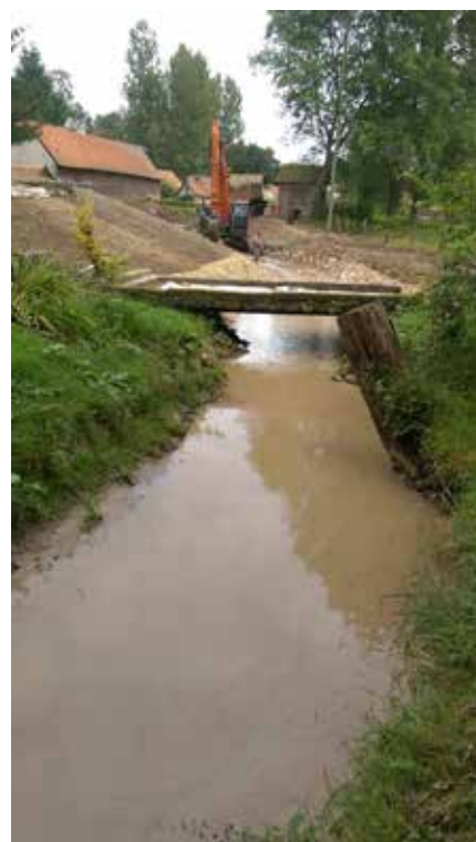
Travaux à l'emplacement de la station sur la Créquoise
