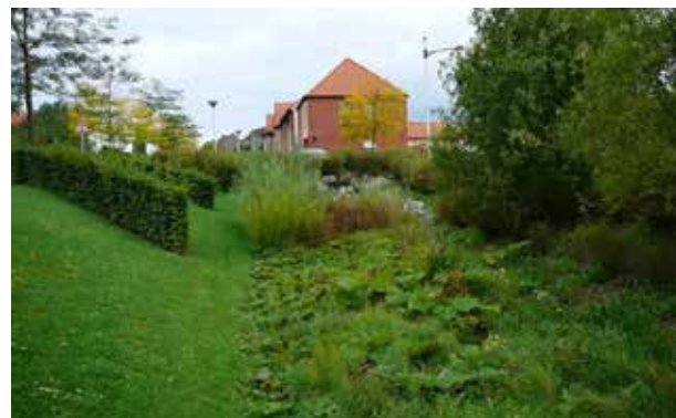
Infiltration des eaux de toiture dans des noues à Bruay la Buissière (62)
