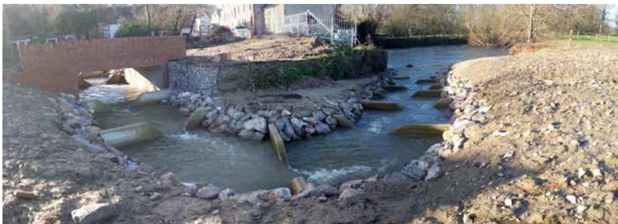
Rivière de contournement du barrage de Mourlinghem
