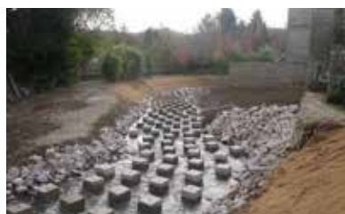
Pose des blocs constitutifs de la passe à macro rugosités
