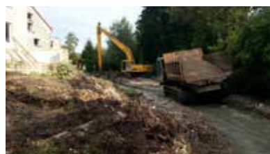
Travaux d'arasement du seuil
