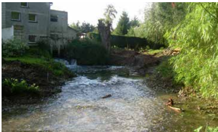
Seuil du moulin de Beussent avant les travaux
