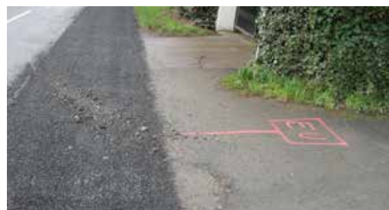
Emplacement d'une future boîte de branchement au réseau nouvellement créée sur la commune de Estrées-Blanche (62)
