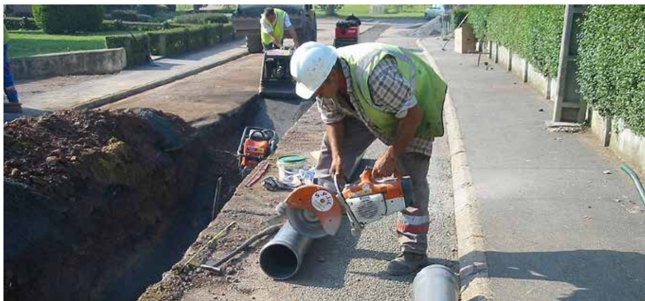
Travaux d'extension réseaux de collecte - LAPUGNOY (62)
