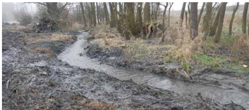
Les berges du Saméon avant travaux
