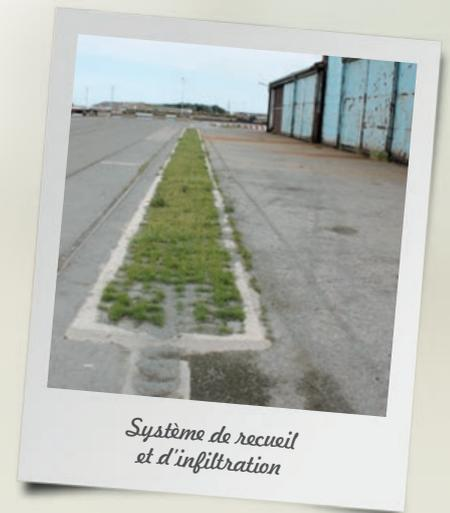
Les ouvrages sont dimensionnés pour infiltrer une pluie de 10 mm en moins de 24h. Au-delà, la faible déclivité du site et les grandes surfaces permettent de stocker les eaux excédentaires sur de très faibles hauteurs (quelques centimètres) et sans gêne pour l'activité portuaire.
