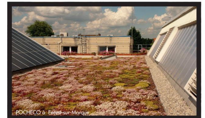
Utilisée sur construction neuve ou existante, elle limite le ruissellement de l'eau par le stockage, l'évapo-transpiration et la consommation d'eau par les plantes.
