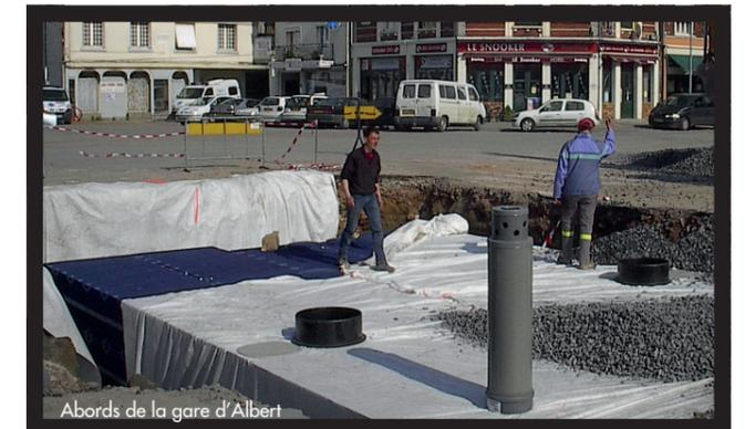
Elles sont mises en œuvre pour la réalisation d'ouvrages enterrés de stockage et restitution. Les eaux pluviales sont infiltrées et/ou rejetées à débit contrôlé vers un exutoire (milieu naturel ou réseau).
