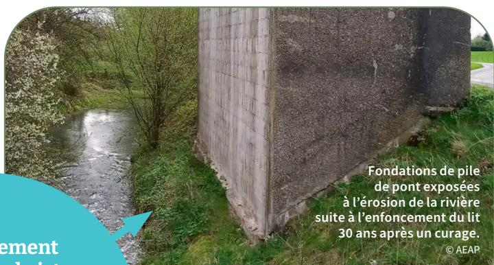
Fondations de pile de pont exposées à l'érosion de la rivière suite à l'enfoncement du lit 30 ans après un curage.
