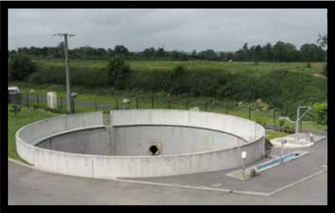
Bassin de stockage restitution à Masnières
