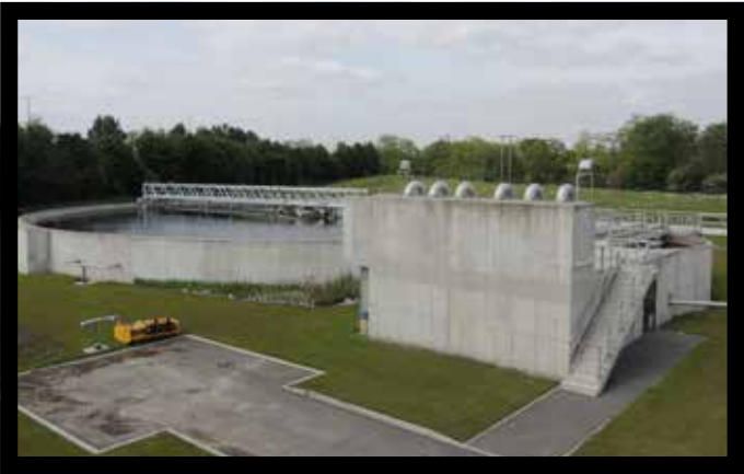
Station d'épuration de Hénil-Beaumont
