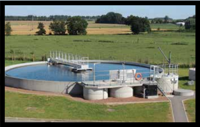
Station d'épuration de Noyelles-sur-Selle
