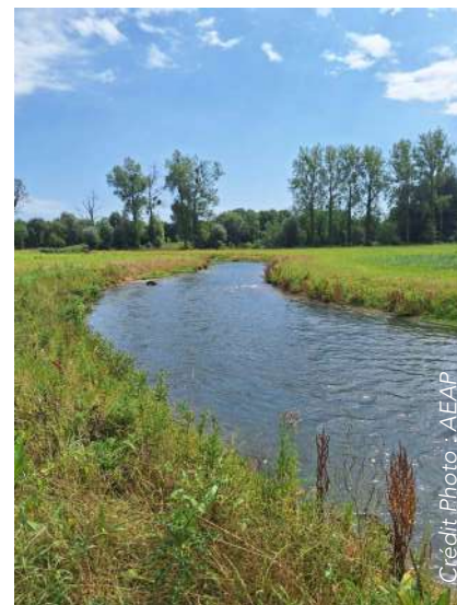
Travaux de restauration cours d'eau d'Huby-Saint-Leu (62)
