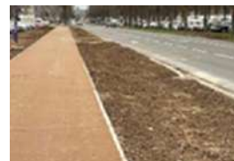
Infiltration des eaux pluviales, Boulevard Faidherbe
