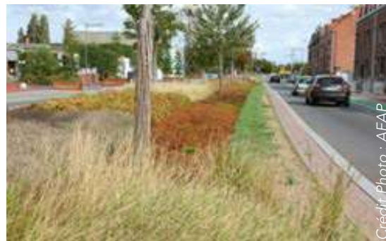
Infiltration des eaux pluviales – Boulevard Vauban à Douai
