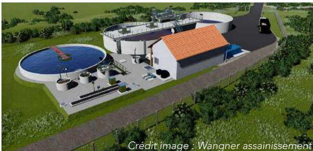
Crédit image : Wangner assainissement Projet de la nouvelle station d’épuration d’Audresselles
