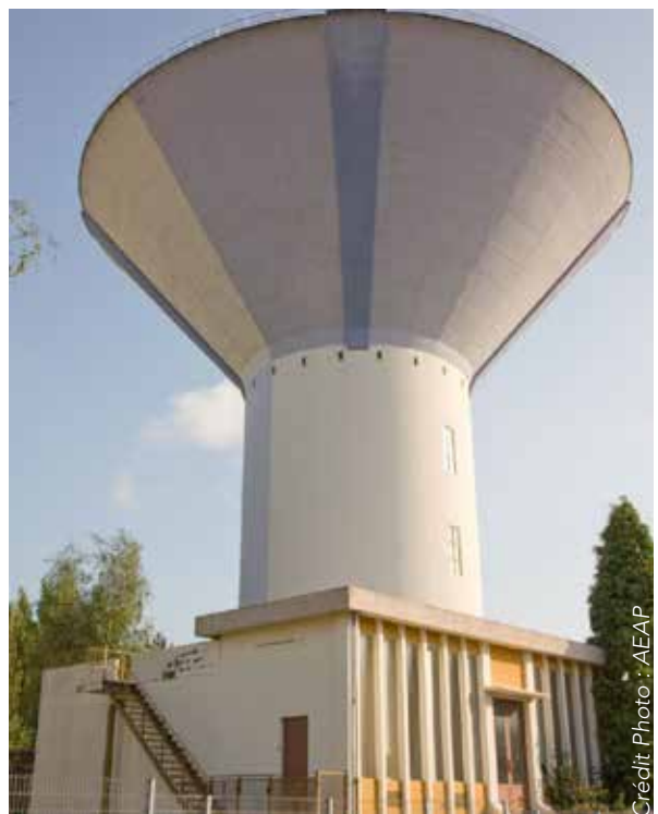
Réservoir d'eau potable dans la métropole Lilloise
