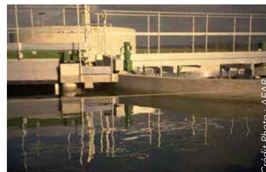
Station d'épuration d'Ecques (62)
