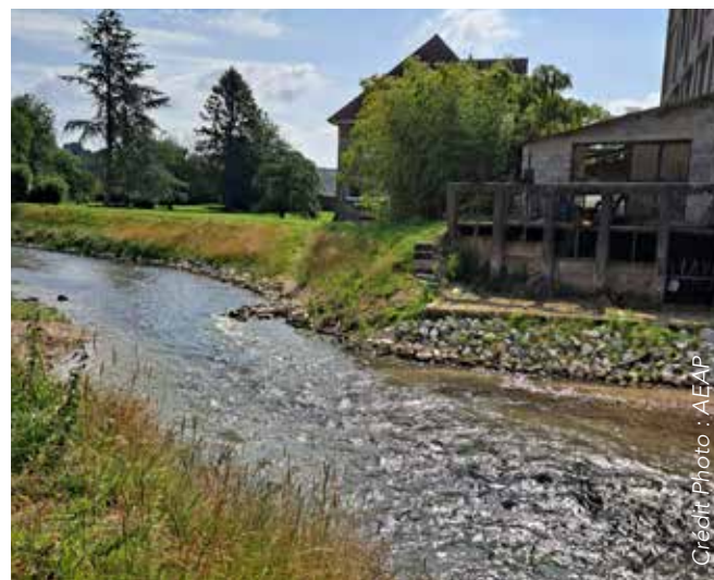
Continuité écologique rétablie au niveau de l'ancien barrage de Fordres à Montcavrel (62)
