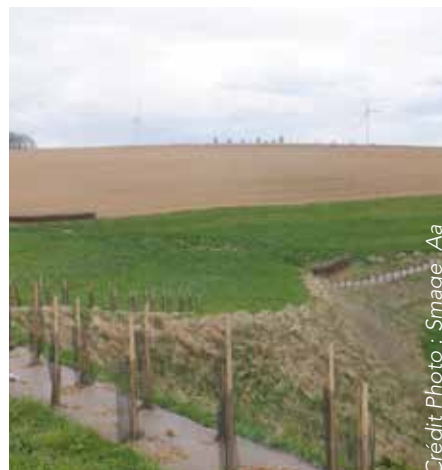
Ouvrages d'hydraulique douce (haie et creuse) à Fauquembergues (62)
