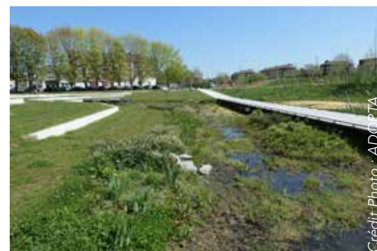
Infiltration des eaux pluviales – Parc Danel à Loos (59)
