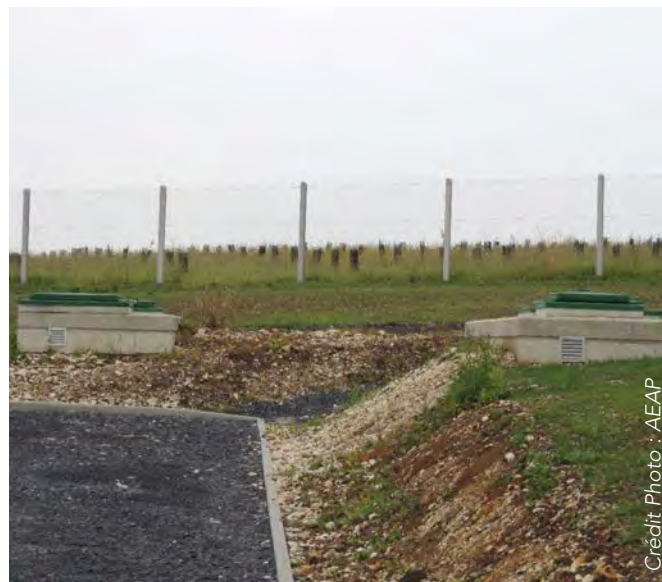
Captage équipé d'un périmètre de protection rapprochée (clôtures) et boisement de l'aire immédiate d'alimentation
