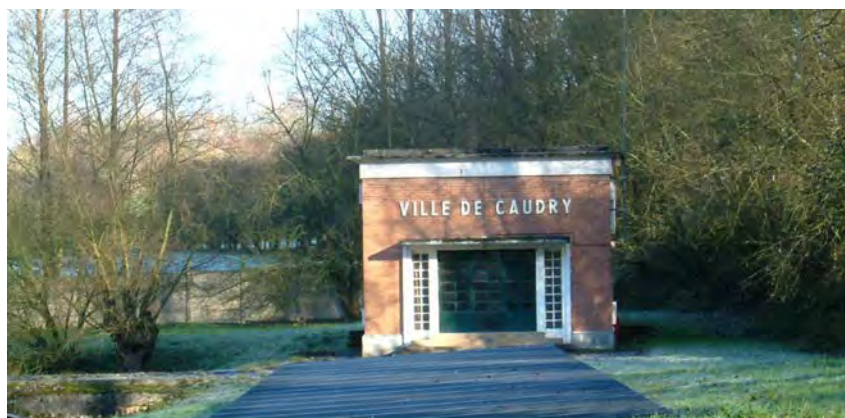
Captage de Saint-Benin à Caudry
