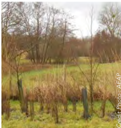
Ouvrage de rétention des ruissellements – Hydraulique « douce »
