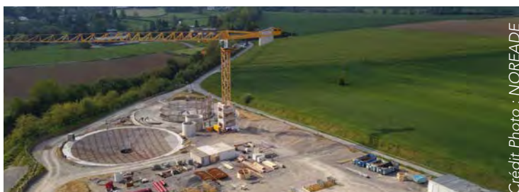
Chantier de la station d'épuration du Cateau Cambresis
