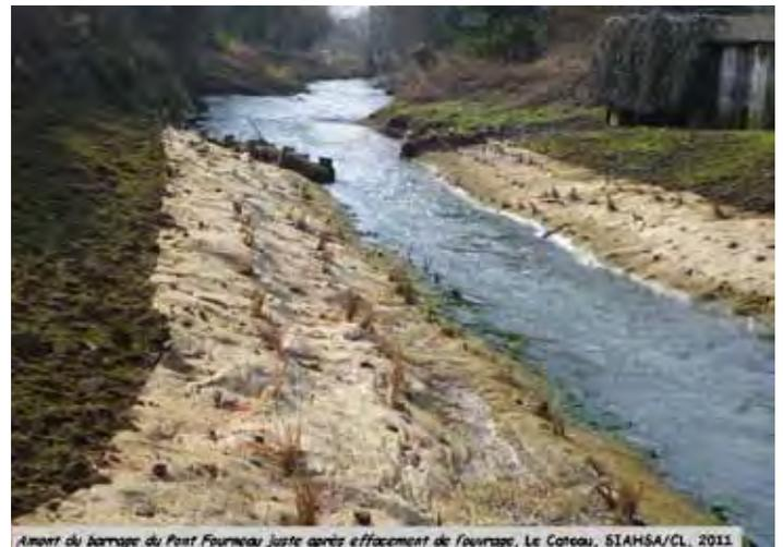
De plus, dans le but d'accroître la diversification des écoulements et le nombre d'habitats piscicoles, des **recharges granulométriques** et des **cache piscicoles** ont été réalisées en amont et en aval des anciens barrages.
